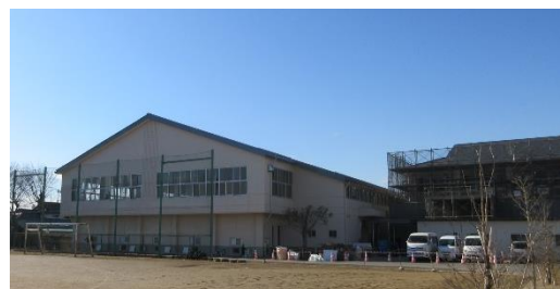
工事中の体育館と西校舎
